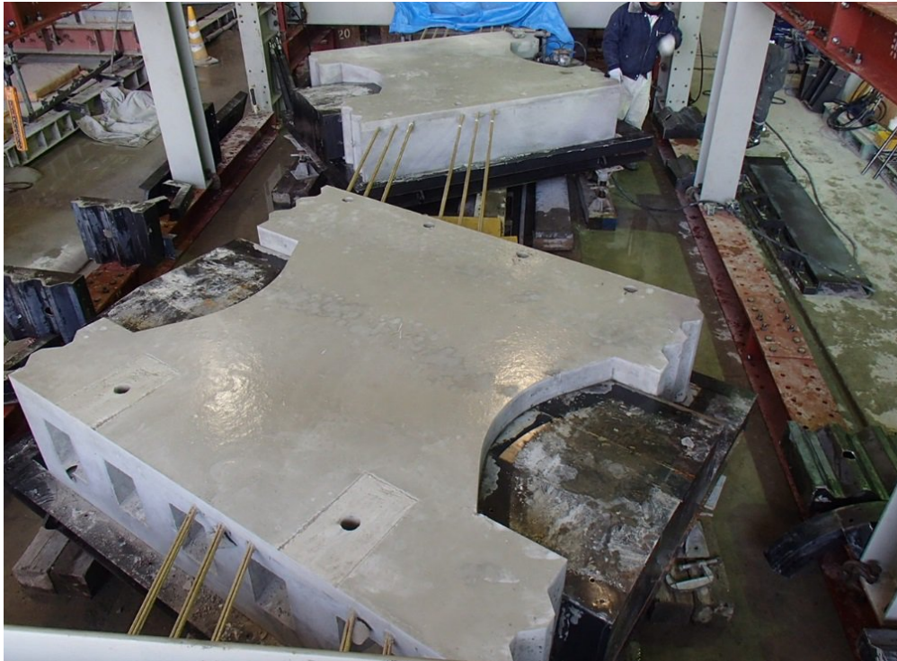
Fabrication of web
