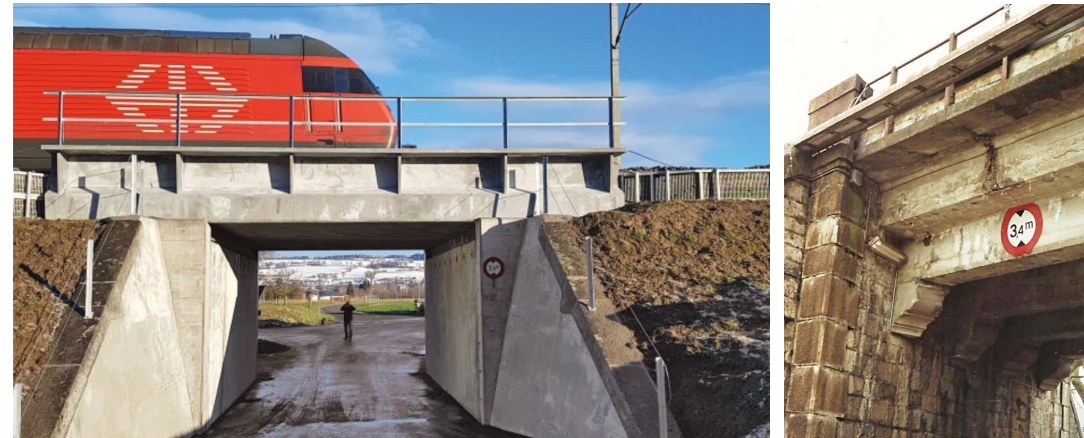
Bild 3 Straßenunterführung Unterwalden nach Abschluss der Bauausführung (Dezember 2017) Road underpass Unterwalden after construction (December 2017)
